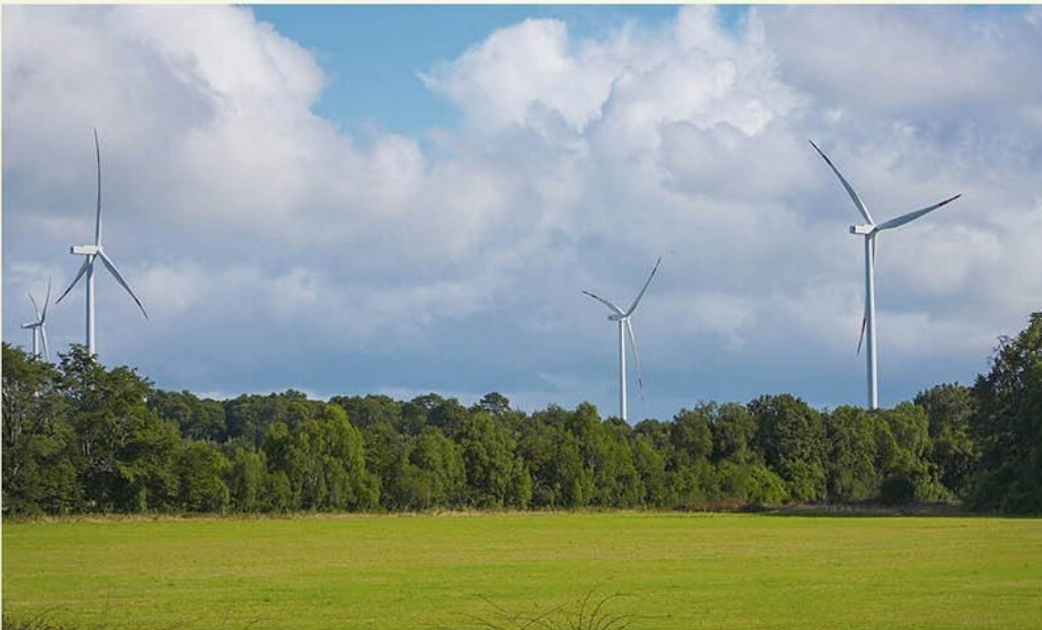
Parque Eólico Aurora, Los Lagos
