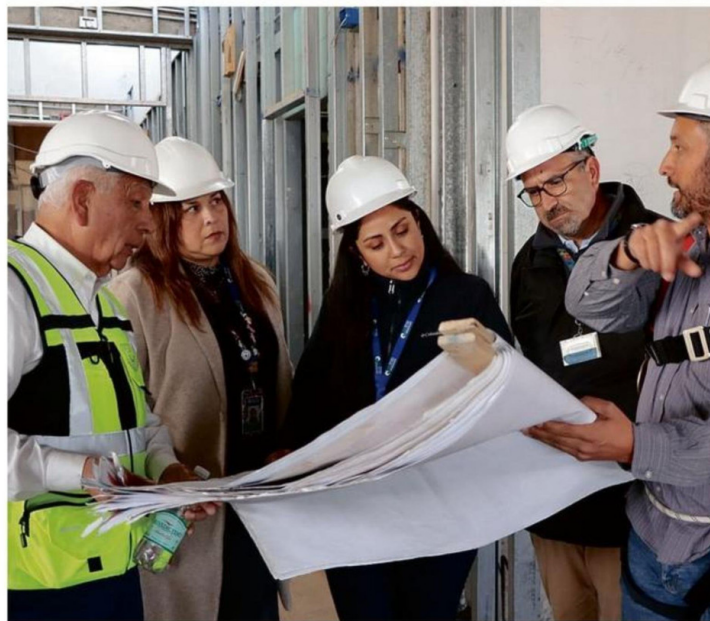
ACTUALMENTE LA OBRA SE ENCUENTRA EN ETAPA DE OBRA GRUESA EXTERIOR.
