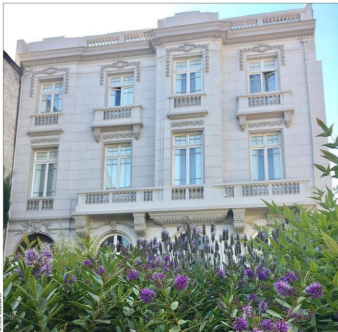
La fachada fue restaurada con lijas. Se reconstruyeron piezas faltantes.
