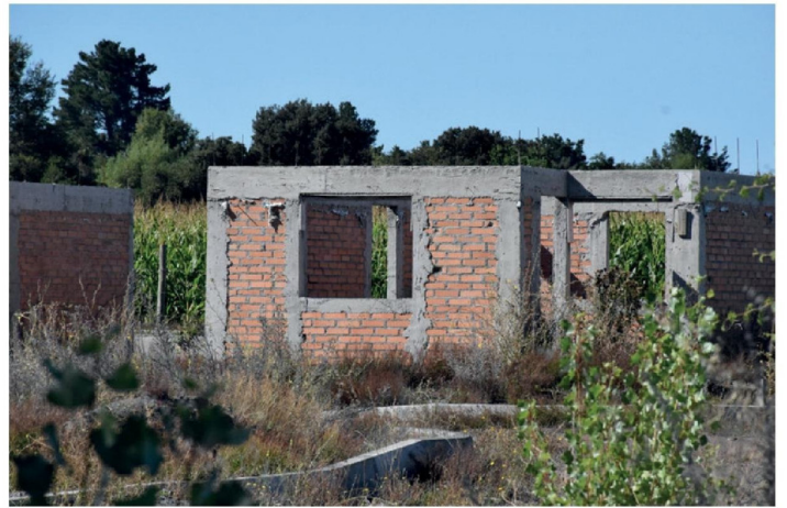
OBRAS DEL PROYECTO HABITACIONAL San Lorencito II y Unión y Esperanza se mantienen detenidas desde septiembre de 2024, a la espera de una solución que permita retomar su ejecución.
