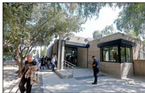
El piso subterráneo es una sala multipropósito con paneles móviles, que puede convertirse en un auditorio para 100 personas.
