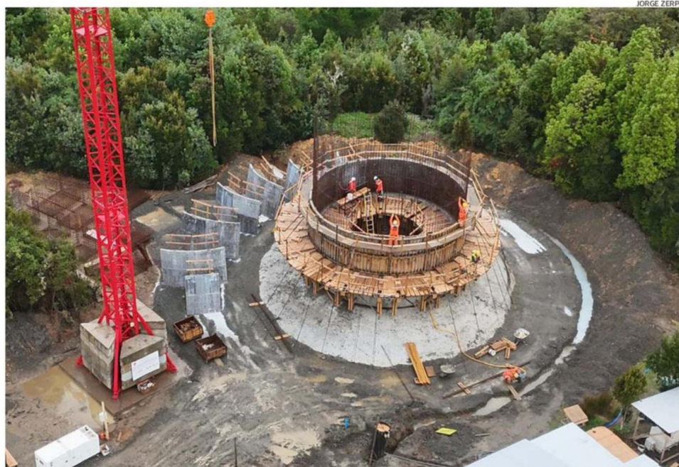
ACTUALMENTE SE CONSTRUYE LA COPA DE 25 METROS DE ALTURA, QUE ALMACENARÁ 200 MIL METROS CÚBICOS DE AGUA POTABLE.
