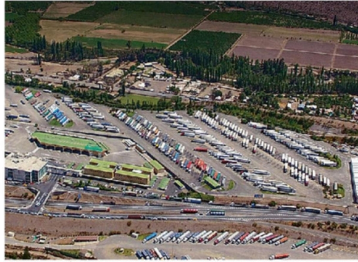
ALZA DEL TRÁNSITO DE CARGA OBLIGA A MODERNIZAR INSTALACIONES.
