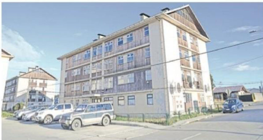
Uno de los edificios del sector Costanera Norte que consta de departamentos fiscales.
