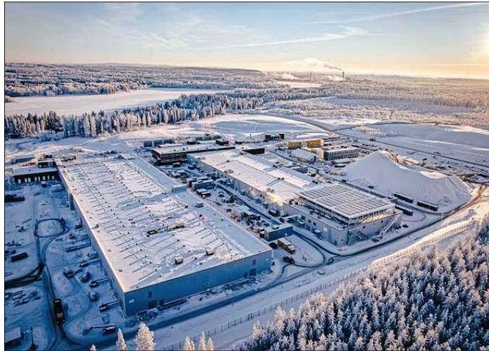
XTX está construyendo un complejo de centros de datos en Finlandia. Se prevé que la primera de las cinco instalaciones entre en funcionamiento a finales de este año.
