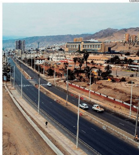
LAS OBRAS DE LA COSTANERA COMENZARON EN FEBRERO DEL 2022.
