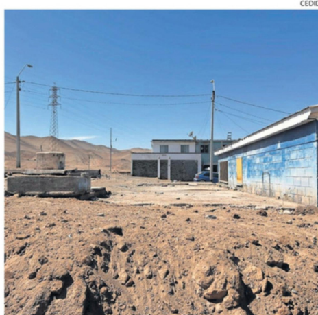
ASÍ ESTÁN LOS ESPACIOS COMUNITARIOS DE ESTE SECTOR DE EL BORO.
