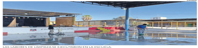
LAS LABORES DE LIMPIEZA SE EJECUTARON EN LA ESCUELA.
