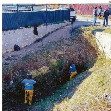
TRABAJOS PREVENTIVOS SE CONCENTRAN EN ZONAS VULNERABLES.
