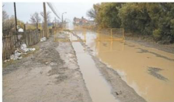
Prolongación Mardones se encontraba completamente inundada y cerrada con vallas.
