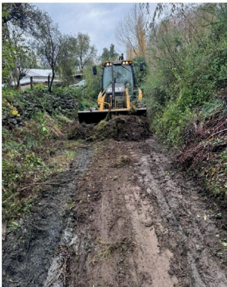
EN EQUIPOS MUNICIPALES de Tucapel realizan trabajos preventivos de limpieza de canales y caminos.
