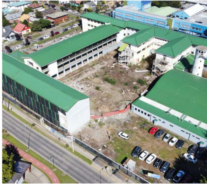
LAS OBRAS DEL LICEO ESTÁN ABANDONADAS DESDE MAYO DEL 2022, POR LO QUE LUCEN DETERIORADAS.
