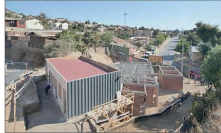
La nueva infraestructura reemplazará la antigua sede social que data de los años 60, dando paso a un recinto moderno de 255 metros cuadrados en dos niveles.
