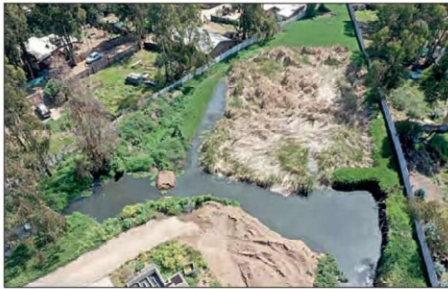
La planta ha generado malos olores, rebalses y filtraciones hacia napas subterráneas.
