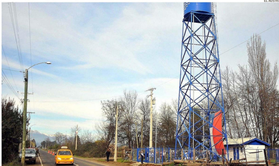
EN LA PROVINCIA OPERAN 48 SERVICIOS DE AGUA POTABLE RURAL AL ALERO DE LA DIRECCIÓN DE OBRAS HIDRÁULICAS (DOH), TODOS CON MOROSOS.
