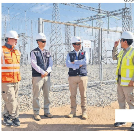
LA SUBESTACIÓN PARINACOTA ES LA PRINCIPAL DE LA REGIÓN.
