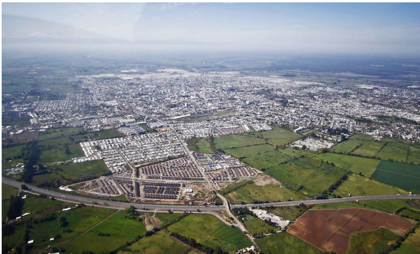
Las obras del proyecto conocido como tercer acceso a Parque Lantaño depende de la concesionaria del tramo Talca-Chillán de la ruta 5 sur.
