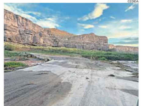
TRABAJOS BUSCAN EVITAR QUE SE ALTERE LA CONECTIVIDAD EN EL LOA.
