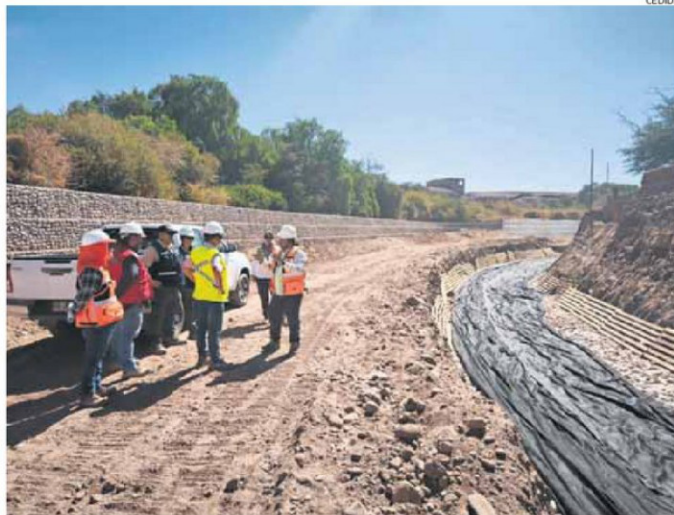
LA SEREMI DEL MOP EFECTUÓ UN RECORRIDO POR LAS PRINCIPALES OBRAS QUE SE EJECUTAN EN EL LOA.
