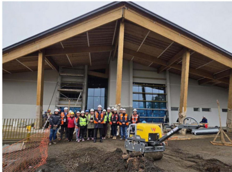
EL RECINTO PRESENTA UN ALTO GRADO DE AVANCE QUE FUE CONSTATADO POR LAS AUTORIDADES DE OBRAS PÚBLICAS.
