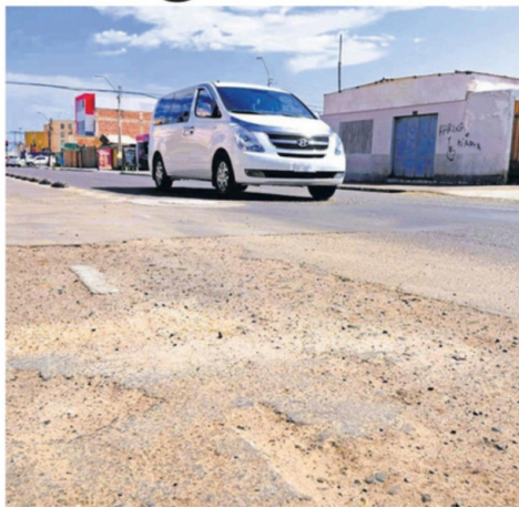
EN ESTA PRIMERA ETAPA SE RENOVARÁN 23 KMS DE PAVIMENTOS.
