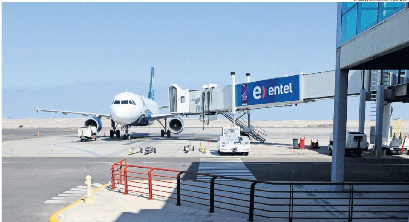
EL AEROPUERTO DE IQUIQUE FUE EL CUARTO TERMINAL CON MAYOR CAÍDA DE MOVILIDAD DE PASAJEROS.
