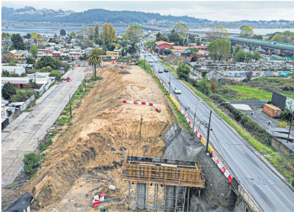
Las obras en el enlace Esmeralda de Concepción apenas alcanzan el 20% de avance tras la salida anticipada de Tapusa.
