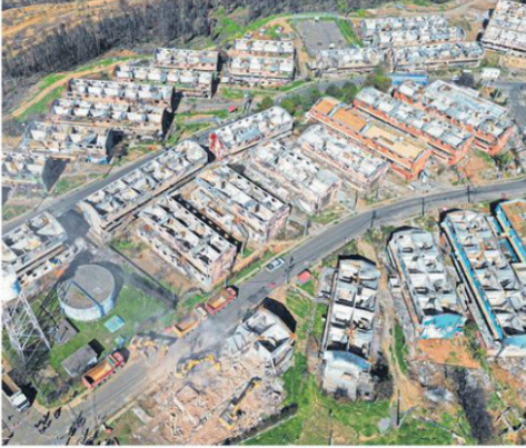
Más de 50 edificios resultaron destruidos por las llamas en enero.
