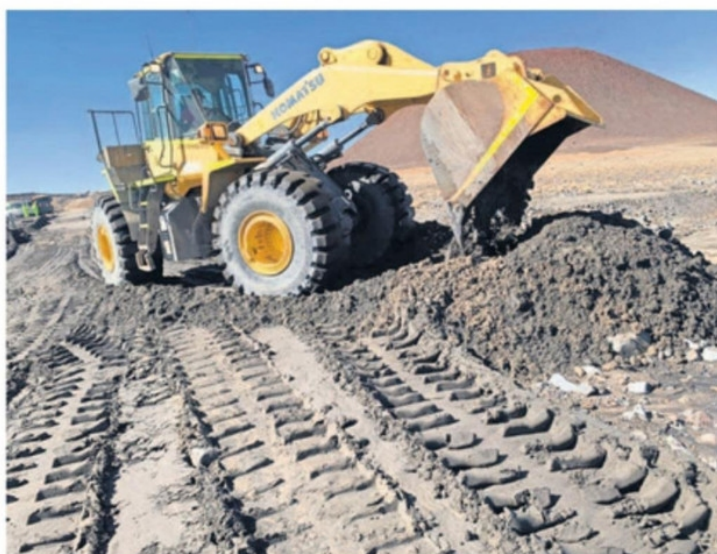
DESPLIEGUE DE MAQUINARIA PESADA EN RUTAS CORDILLERANAS.
