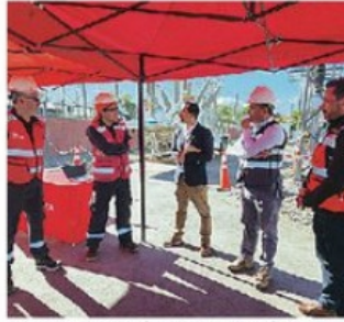
SEREMI VISITÓ SUBESTACIÓN.
