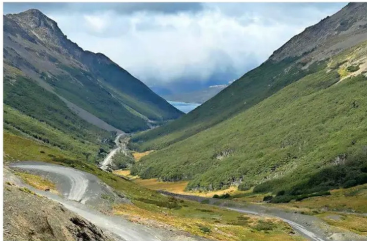
Uno de los tramos del camino Vicuña-Yendegaia ya construidos serpentea en las inmediaciones de la cordillera Darwin.
