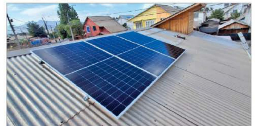
La sede vecinal de Villa Provincial de Rancagua ahora cuenta con paneles fotovoltaicos para su uso diario, lo que le permitirá ahorrar casi la totalidad del consumo eléctrico.
