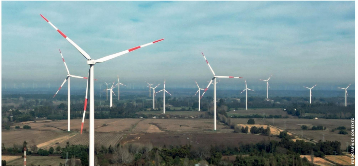
EL PARQUE EÓLICO RINCONADA contempla una inversión cercana a los USD 365 millones y se emplaza entre las comunas de Laja y Los Ángeles.
