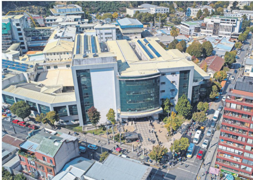
El Hospital Regional del Biobío, referencial para toda la zona sur del país, tendría una disminución de $2 mil 696 millones en su presupuesto.
