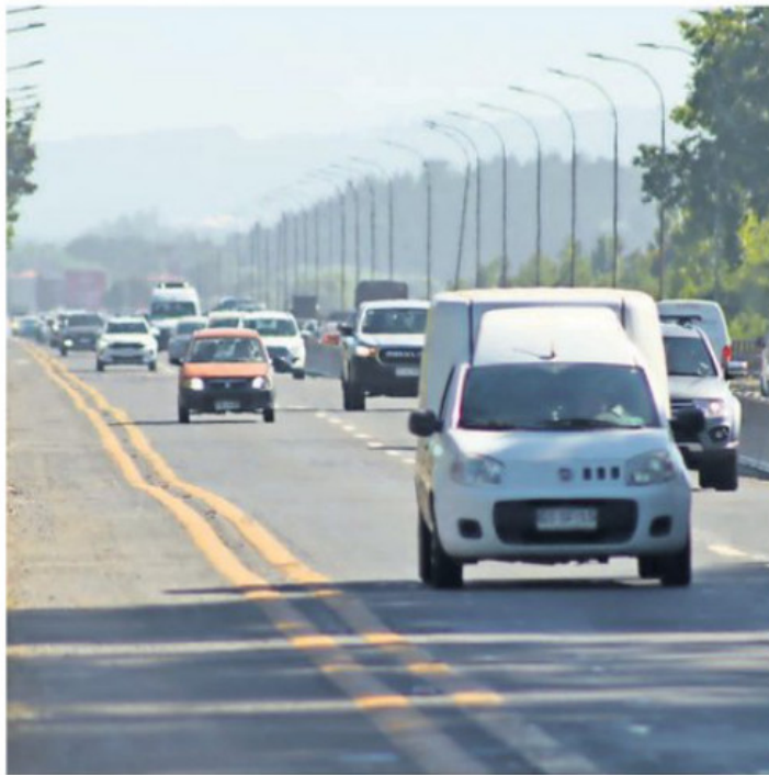
Por el puente está prohibido el paso de camiones.
