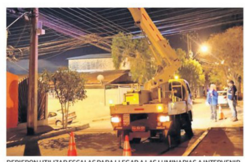
DEBIERON UTILIZAR ESCALAS PARA LLEGAR A LAS LUMINARIAS A INTERVENIR.
