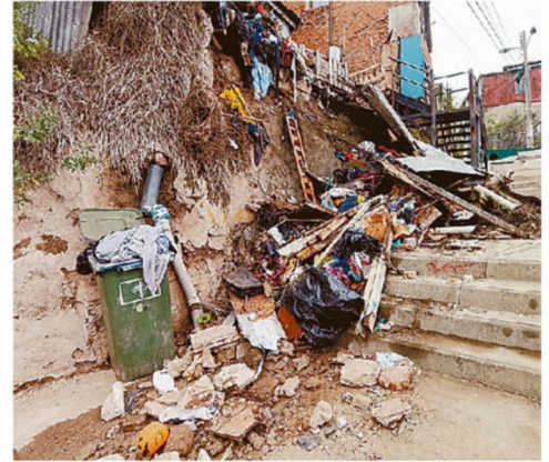
ESCALERA DE LA ZONA QUEDÓ INTERRUMPIDA POR ESCOMBROS.
