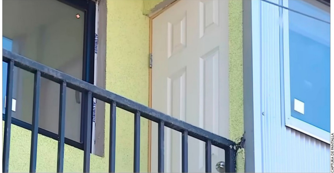
Abogada querellante por demolición en El Olivar: “Lo que ocurrió aquí es absolutamente anormal!”
