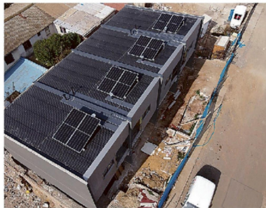
OBRAS DE LA CONSTRUCTORA SAN SEBASTIÁN SERÁN DEMOLIDAS.
