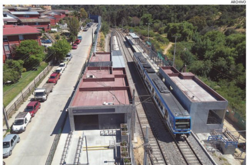
LA ÚLTIMA ESTACIÓN QUE SE CONSTRUYÓ EN EL TRAZADO REGIONAL FUE LA ESTACIÓN VALENCIA.
