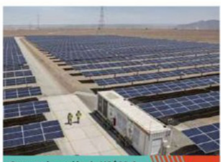
Con una inversión de US$29,4 millones, Subestación Andacollo proyecta empleo local.
