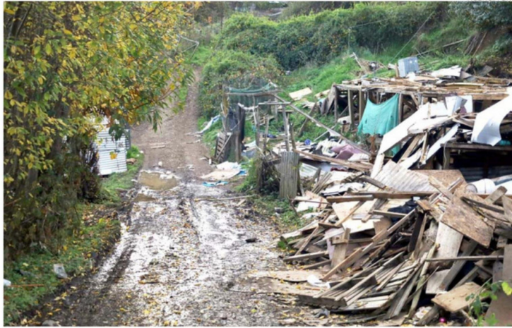
LA LIMPIEZA DEL TERRENO CONTEMPLA EL RETIRO DE TONELADAS DE BASURA ACUMULADAS POR AÑOS.
