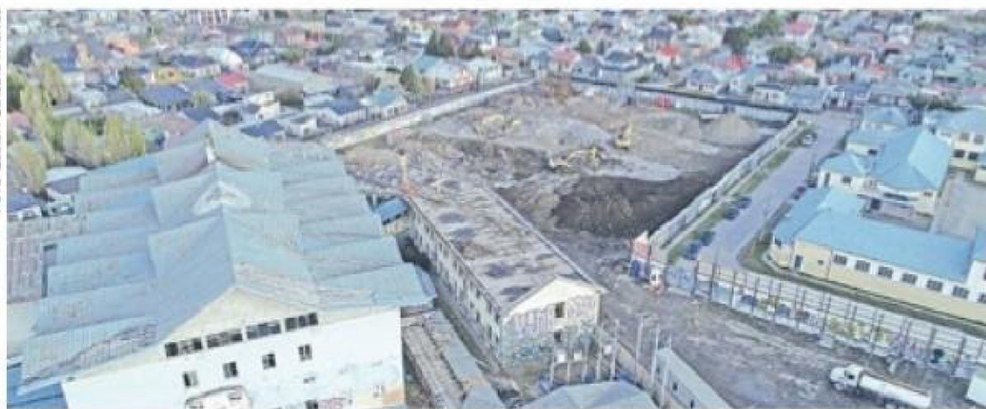
Así avanza la demolición del antiguo hospital de calle Angamos.
