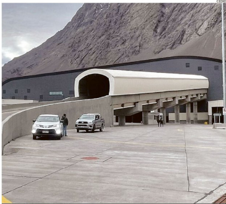
SE ESPERA QUE TRABAJOS PUEDAN COMENZAR ENTRE LOS MESES DE SEPTIEMBRE Y OCTUBRE DE ESTE AÑO.
