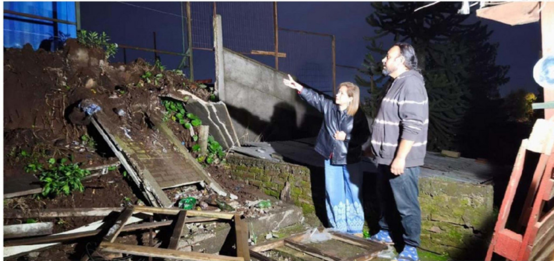
FAMILIAS Y ADULTOS MAYORES DEL SECTOR ESTÁN PREOCUPADOS POR LOS TRABAJOS ABANDONADOS Y EL RIESGO DE ACCIDENTE.
