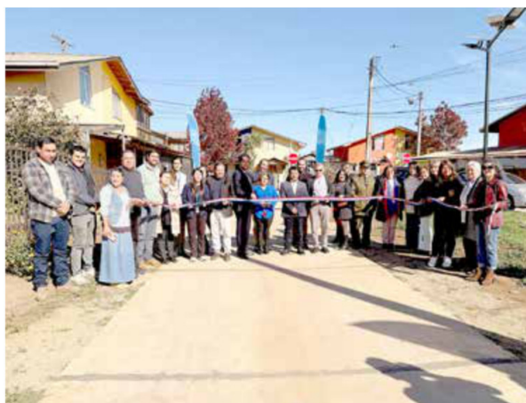
El seremi de Vivienda Patricio Ponce y el alcalde de Constitución, Carlos Valenzuela, encabezaron la inauguración de la obra de pavimentación en la Villa Nueva Vaquería.
