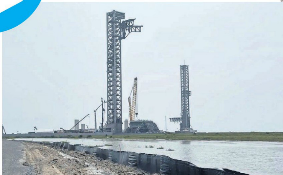
PLATAFORMA DE LANZAMIENTO DE LA EMPRESA AEROSPECIAL SPACEX EN LA CIUDAD DE STARBASE A LAS AFUERAS DE BROWNSVILLE, EE.UU.
