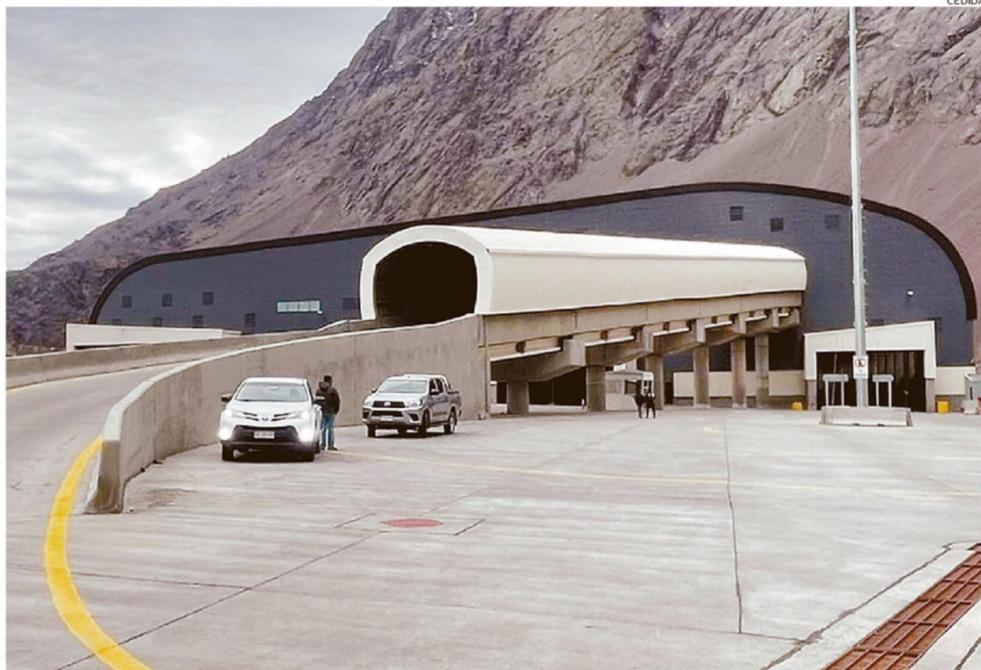
TRABAJOS COMENZARÍAN ENTRE SEPTIEMBRE Y OCTUBRE Y SE EXTENDERÍAN POR 18 MESES, DETENIENDO LAS OBRAS DURANTE EL INVIERNO.
