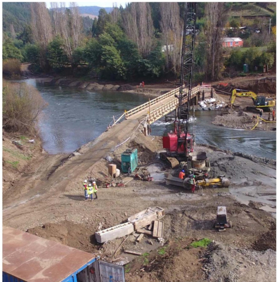
SE ESPERA QUE LA EJECUCIÓN DE LA OBRA SE DESARROLLE EN LOS PLAZOS ESTABLECIDOS, CON COORDINACIÓN PERMANENTE CON LOS MUNICIPIOS DE LUMACO Y GALVARINO Y LAS COMUNIDADES DEL SECTOR.
