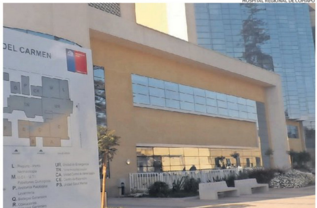
HOSPITAL REGIONAL DE COPIAPÓ
