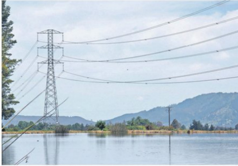
La línea de transmisión está ubicada en Cabrero.
